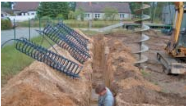
Einbau der Spiralkollektoren
